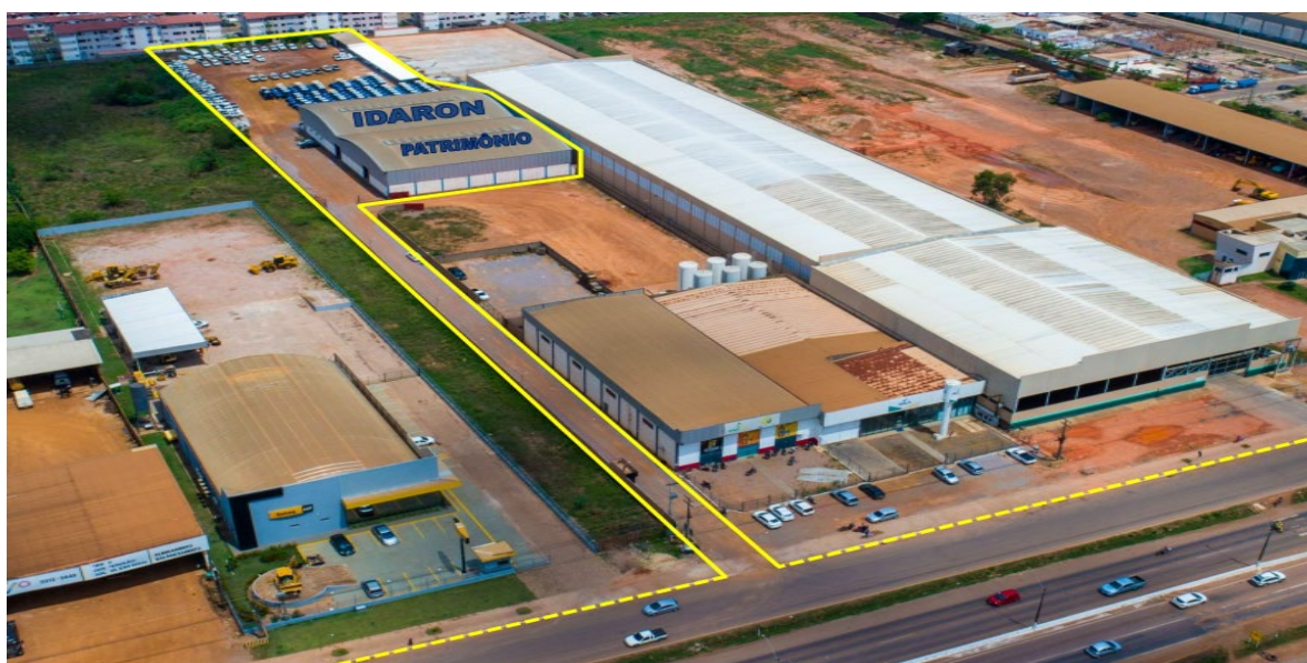
Figura 12: Foto Aérea 2 - Vista Frontal Depósito da IDARON
