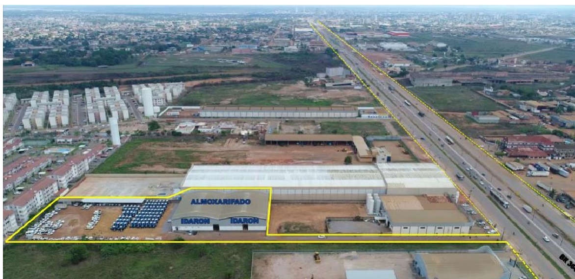
Figura 13: Foto aérea 1 - Vista Lateral Depósito da IDARON
