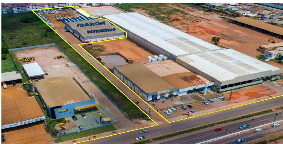
Figura 14: Foto aérea2 - Vista Frontal Depósito da IDARON.
