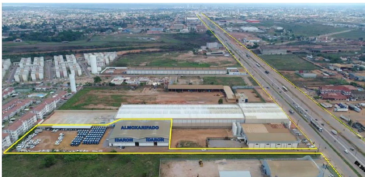
Figura 13: Foto aérea 1 - Vista Lateral Depósito da IDARON
