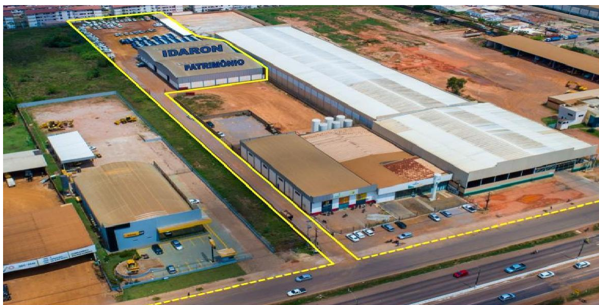
Figura 14: Foto aérea2 - Vista Frontal Depósito da IDARON.
