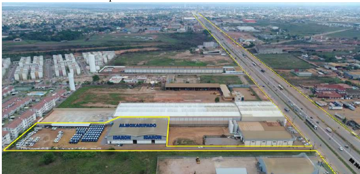
Foto Aérea 1 – Vista Lateral Depósito da IDARON
