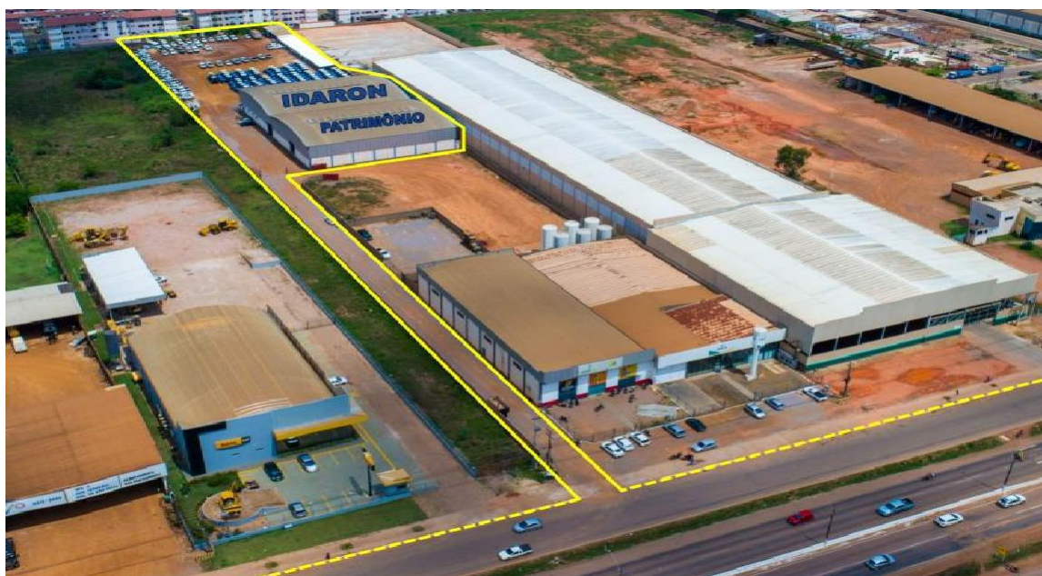
Figura 10: Foto Aérea 2 - Vista Frontal da IDARON
