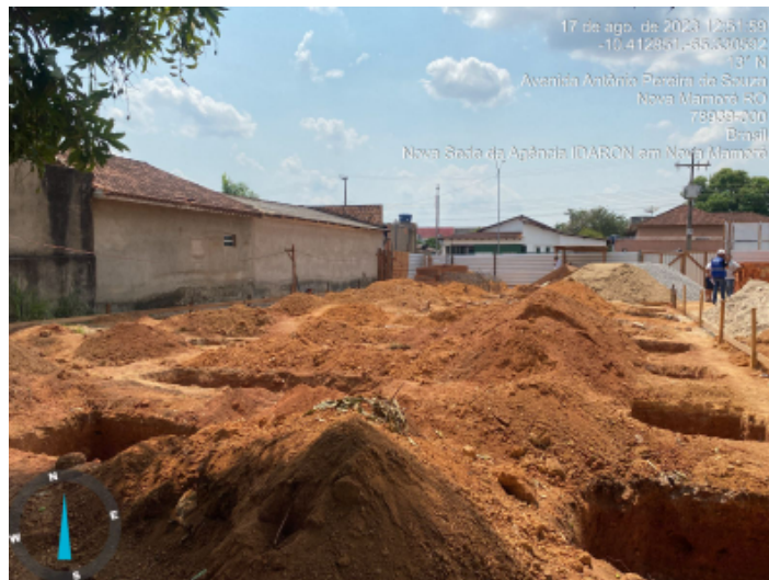
Construção da Unidade de Nova Mamoré. EM EXECUÇÃO Valor total do contrato: R$ 1.213.675,87
