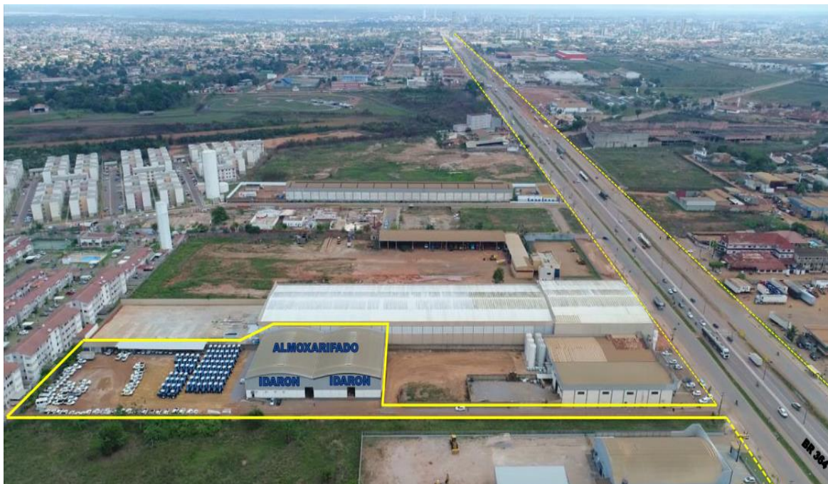
Figura 9: Foto Aérea 1 - Vista Lateral Depósito da IDARON.
