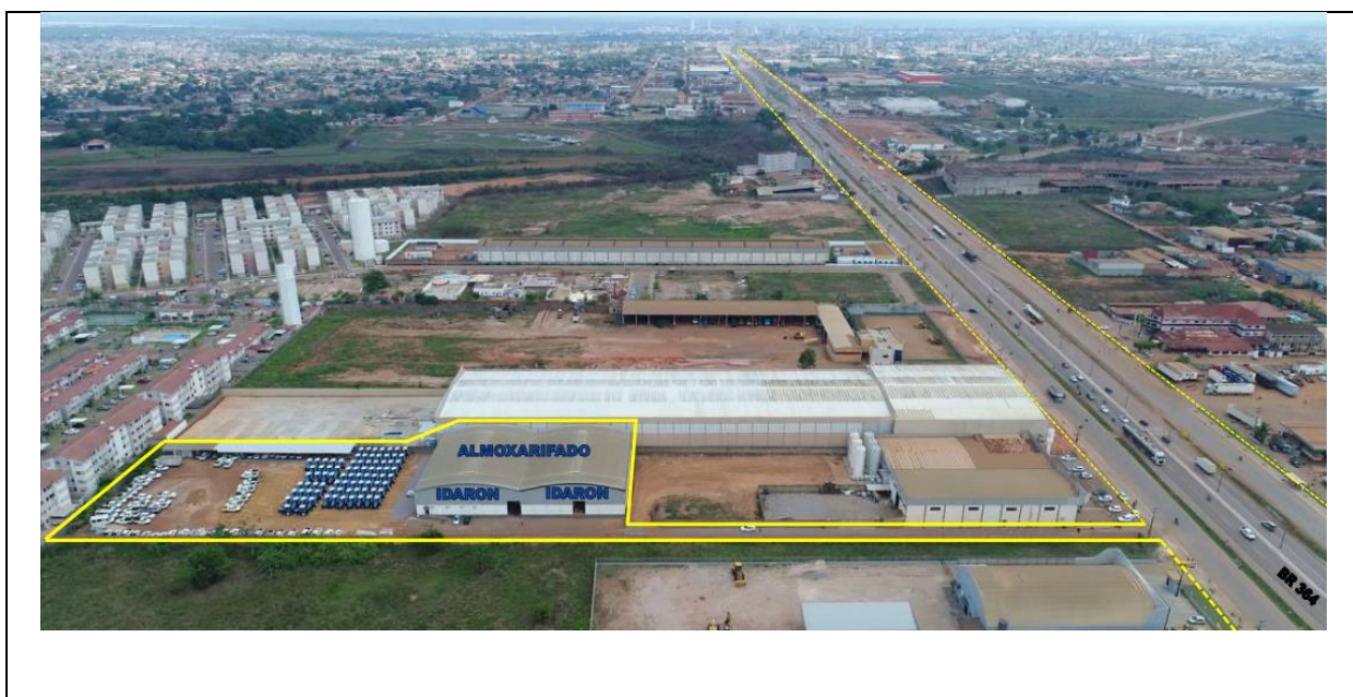
Figura 11: Foto Aérea 1 – Vista Lateral Depósito da IDARON.
