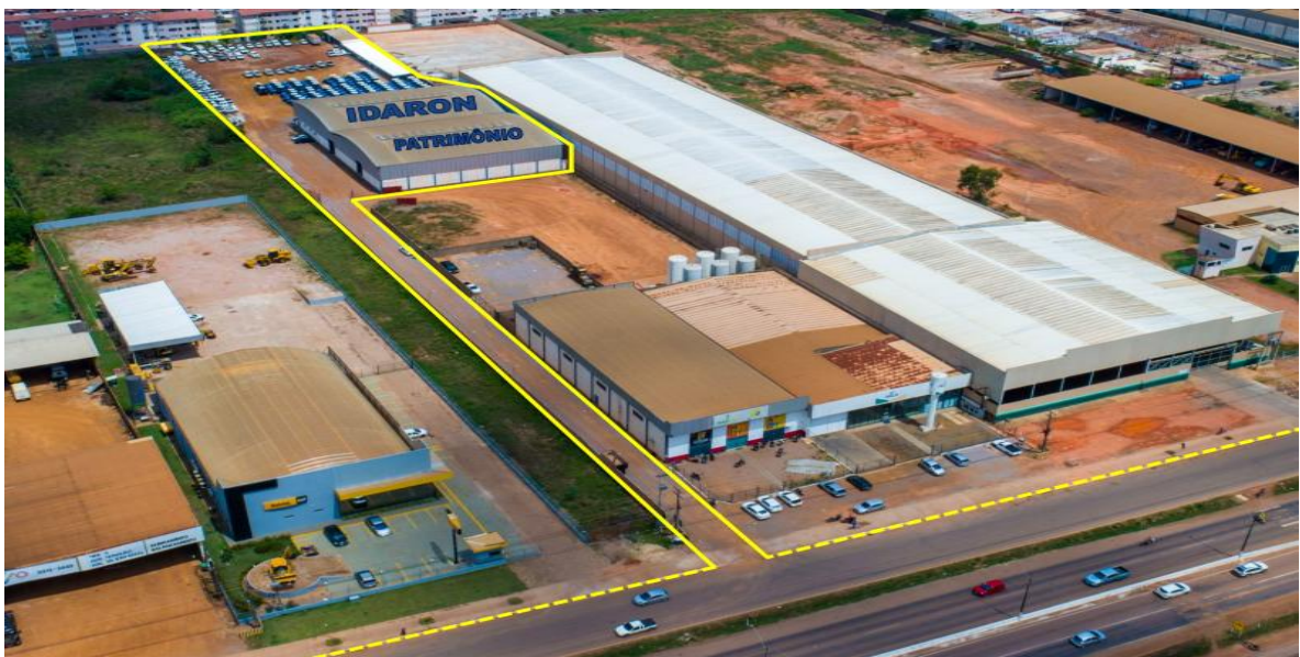
Foto Aérea 2 - Vista Frontal Depósito da IDARON
