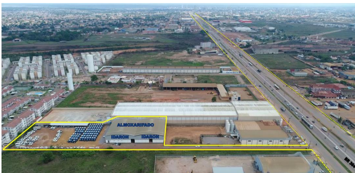
Foto Aérea 1 – Vista Lateral Depósito da IDARON
