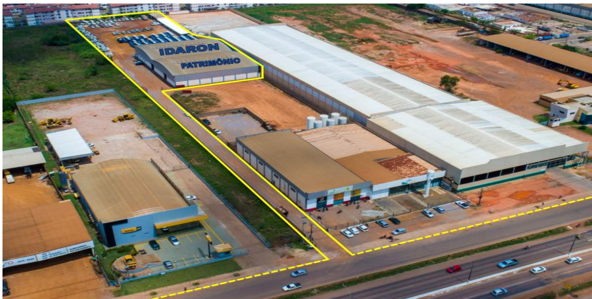
Foto Aérea 2 - Vista Frontal Depósito da IDARON
